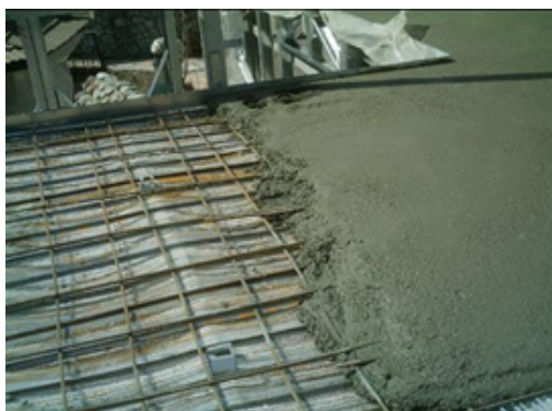
بتن ریزی سقف
