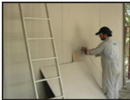
نصب گچ برگ در دیوارهای داخلی
