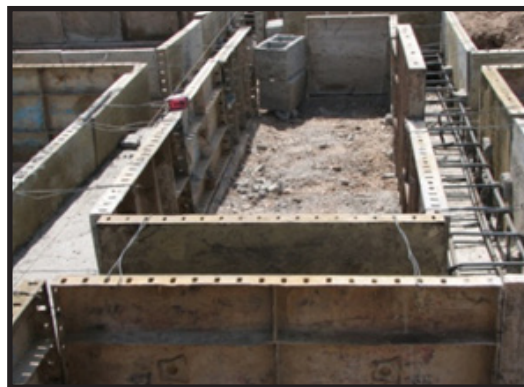
قالب بندی فونداسیون
